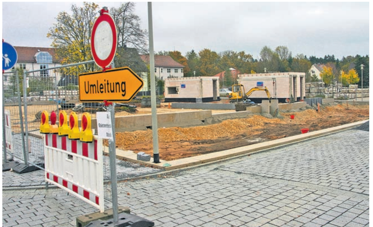
Am Schwarzenbrucker Plärrer gehen die Arbeiten zügig voran. Hier soll im Dezember wieder der Weihnachtsmarkt stattfinden. Foto: Blinten
